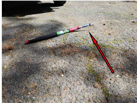
Notice uneven asphalt under pole
