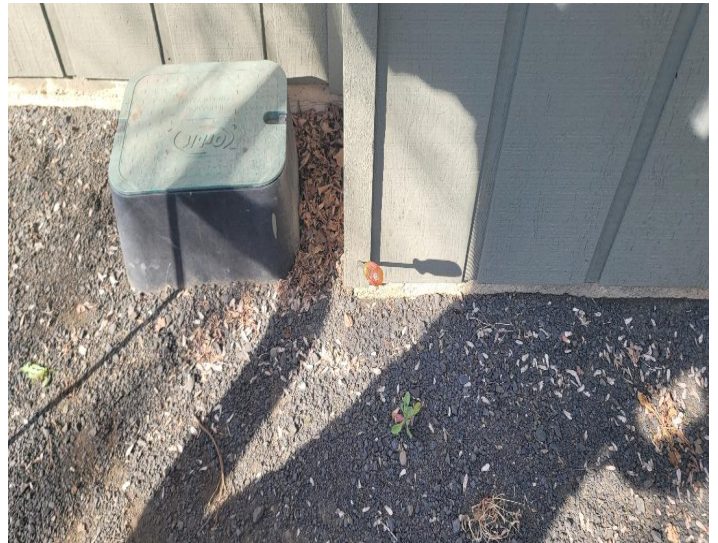
3A - Damaged trim.
