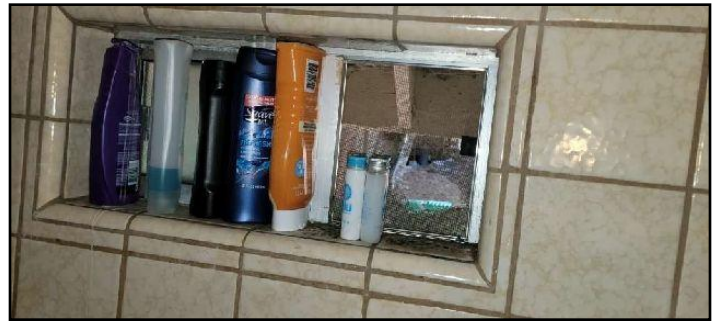
20. Torn or holes
