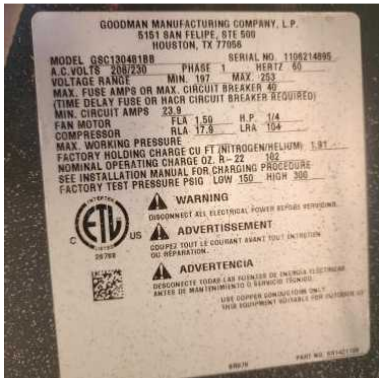
AC Condenser Placard
