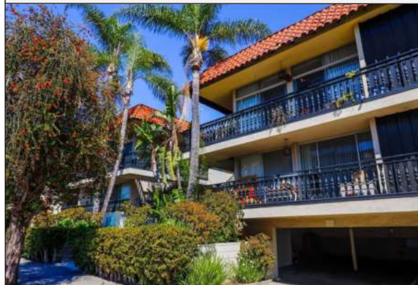
3) 11978 KIOWA AVE. UNIT #105
